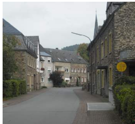
Abbildung 30: Straßenausbau Osann (Altortsbereich Moseltalstraße)
