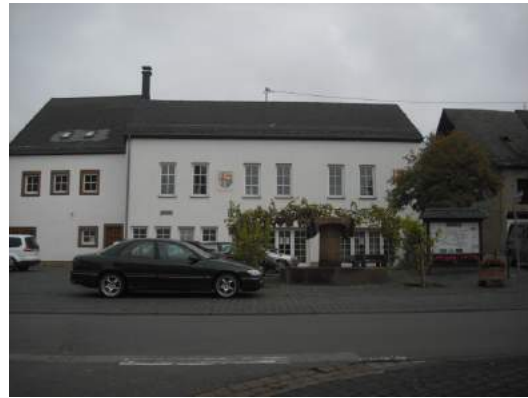
Abbildung 13: Vorplatz Gemeindehaus Osann
